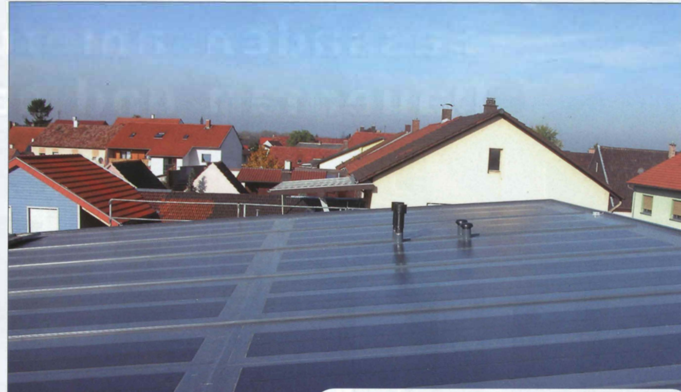
Mehr als die Hälfte der Befragten würden ein Dach bevorzugen, das sich mit Solarzellen ausstatten lässt. Foto: djd/BetonBild, Erkrath Bild rechts: Betondächer haben gute Wärmedämm-Eigenschaften, moderne Konzepte wie „iRoof“ liefern durch die Verbindung von Photovoltaik und Wärmetauscher sogar Energie. Foto: djd/BetonMarketing Deutschland GmbH
