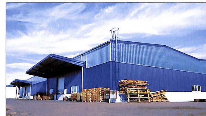
Eine der Fertigungshallen in Dunajská Streda (Slowakei)
