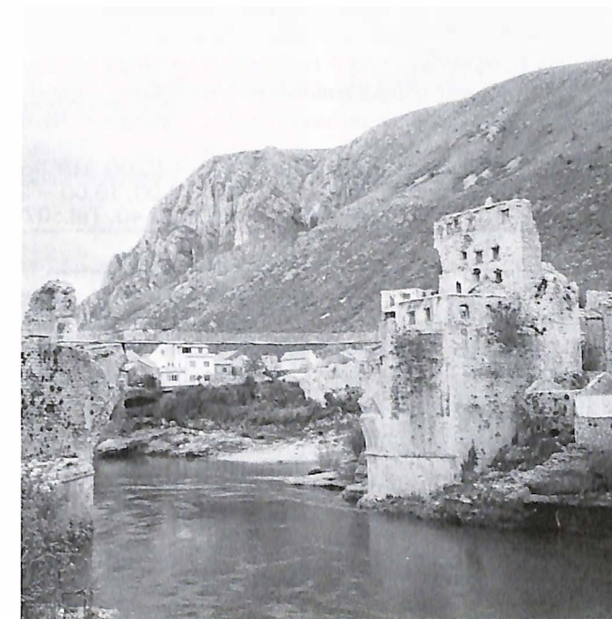
Mostar, an dieser Stelle befand sich die historische Steinbrücke über die Neretva
