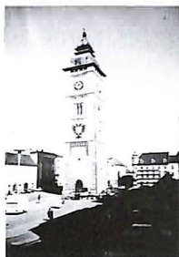
Enns, Stadtturm erbaut 1564 - 1568
