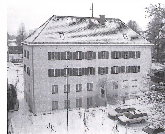
Ansicht des neuen „alten“ GP Wolfsberg
