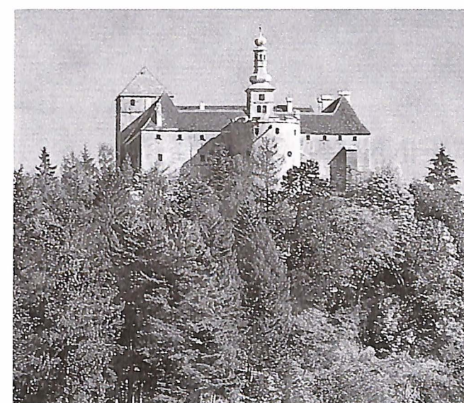
Die von den Herren von Krumbach im 13. Jahrhundert errichtete Burg beherrscht das gesamte Landschaftsbild des Krumbacher Beckens. Als Schloß Krumbach wird es nun im Einvernehmen mit dem Bundesdenkmalamt zu einem Gesundheitshotel umgebaut
