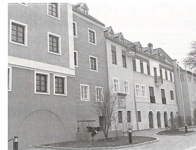
Die neu eröffnete Außenstelle der SchA des LGK f.NÖ.
