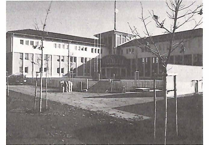
Das neue Sicherheitszentrum
