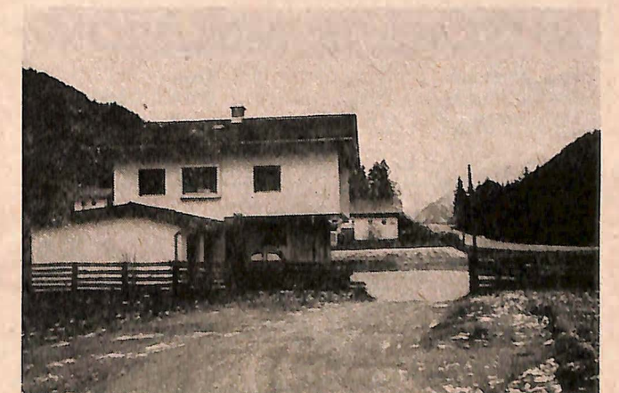
Die Unterkunft des neuen Gendarmeriepostens in Mittewald an der Drau, Bezirk Lienz.
