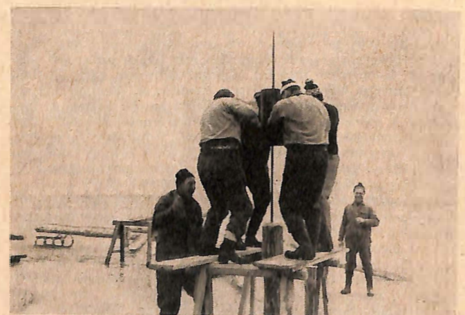
Einschlagen einer Plote für den unternommenen Zubau.
