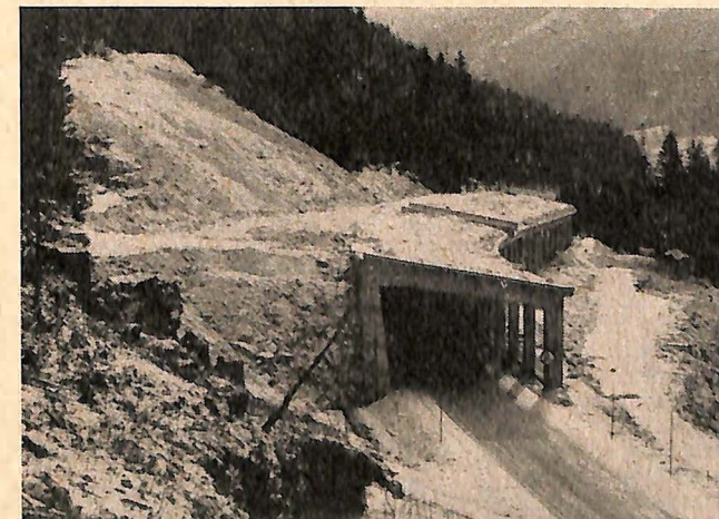
Gesamtansicht einer Lawinengalerie (470 m) vor der Fertigstellung (Photo: Heinrich Occlon, St. Johann im Pongau)
