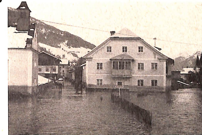
Die westliche Ortseinfahrt von Sillian; der höchste Wasserstand ist am Mauerwerk noch zu sehen
