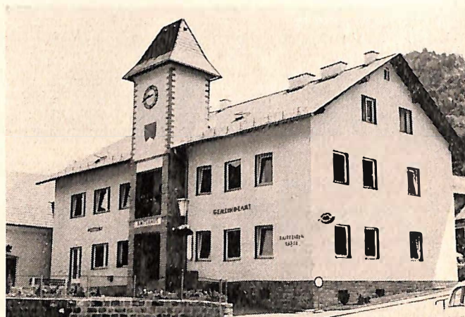
In einem Neubau der Gemeinde Frankenfels, Bezirk Sankt Pölten, Niederösterreich, erhielt der dortige Gendarmerieposten mit 1. Oktober 1965 eine neue Unterkunft
