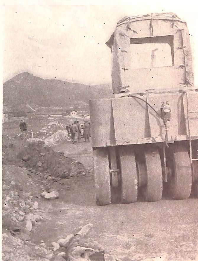
Mangelnde Vorsicht und Waghalsigkeit im Betrieb von schweren Baumaschinen fordern immer wieder Opfer
