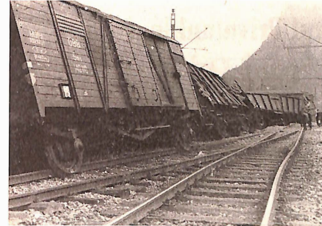
Aus den Schienen gehobene und umgeworfene Waggons sowie . . .
