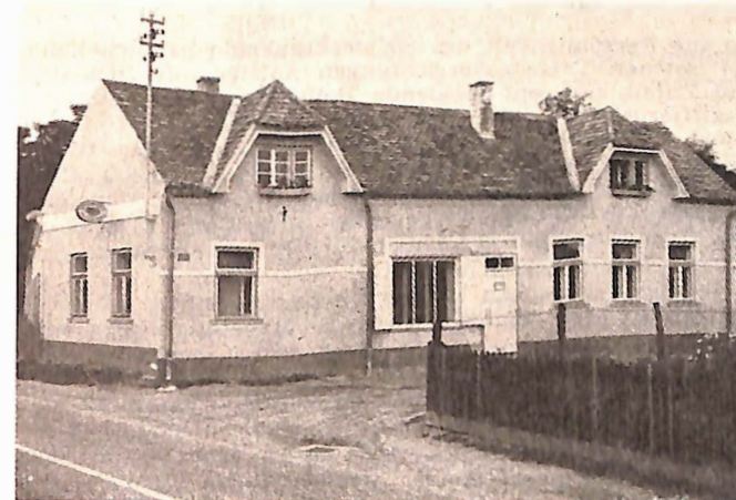
Diese schöne, neue Unterkunft hat das Gendarmeriepostenkommando Niederrußbach, Bezirk Korneuburg, Niederösterreich, am 1. April 1960 in Benützung genommen.
