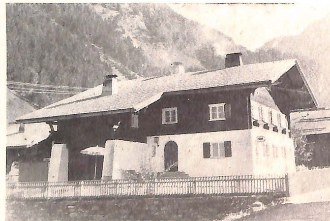
Das Gendarmeriepostenkommando Partenen, Vorarlberg, hat am 1. Juli 1962 neue, moderne Arbeitsräume in Benützung genommen
