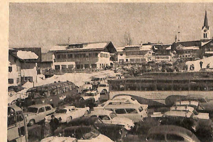
Kraftfahrzeugverkehr bei der Talstation der Kanzelwand-Seilbahn in Riezlern
