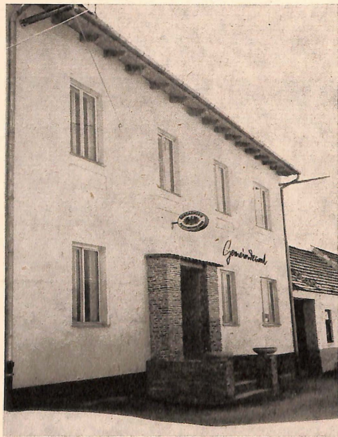
Die neue Gendarmeriepostenunterkunft in Hauskirchen, Niederösterreich
