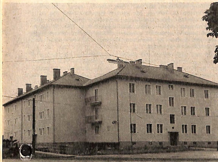
Gesamtansicht des neuen Gendarmeriegebäudes in Leibnitz
