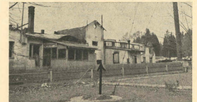
Ansicht der östlich angelagerten Nebengebäude. Der Pfeil zeigt den Schaltraum. Im rechten Ende des Flügels befand sich die Dampfmaschine.
