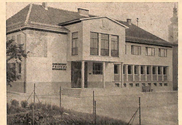
Die neue Gendarmeriepostenunterkunft in Offenhausen, Oberösterreich
