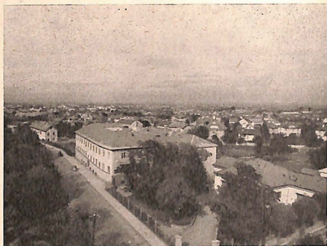
Kommandogebäude der Gendarmeriezentralschule Mödling, Vorderansicht
