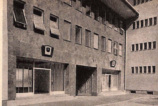
Gendarmerietrakt des neuen Amtshauses in Hallein, Salzburg
