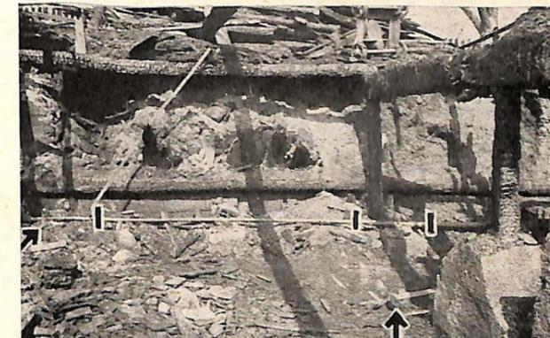
Abb. 4: Teilaufnahme der im Sägespänekeller verlaufenden Transmissionswelle. Pfeil links weist auf die Reste des Lagers 1 hin, Pfeil Mitte auf die des Lagers 3
