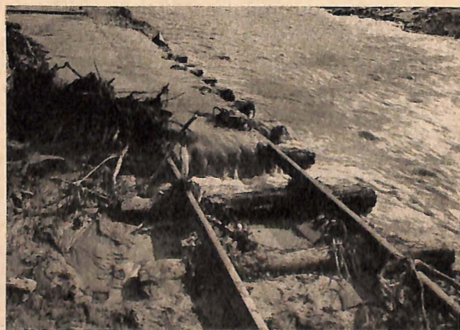
Ueberschwemmte Geleise der Landesbahn Mixnitz-St. Erhard
