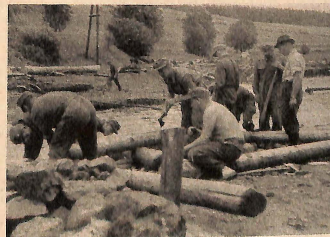
Bau einer Behelfsbrücke über den Jasnitzbach durch die Gendarmierschule des Bundesministeriums für Inneres
