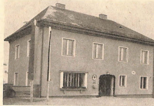
Mit dem Bau des neuen Amtsgebäudes der Gendarmerie und Post in Idolsberg, Niederösterreich, wurde am 23. Juli 1956 begonnen und dasselbe am 4. Februar 1958 offiziell und feierlich seiner Bestimmung übergeben. Außer den beiden Aemtern ist noch eine geräumige und moderne Wohnung für einen Gendarmeriebeamten vorhanden
