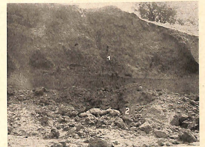
Abstürzende Lehm Massen töteten einen Arbeiter
