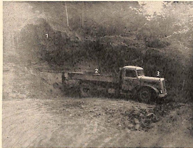
Lastkraftwagen, welcher in einer Sand- und Schottergrube vorschriftswidrig beladen wird
