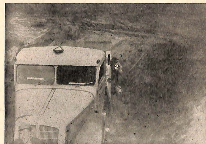
Rekonstruktion des in eine Sandgrube eingefahrenen Lastkraftwagens mit den abgestürzten Sandmassen, wobei ein Arbeiter schwer verletzt wurde
