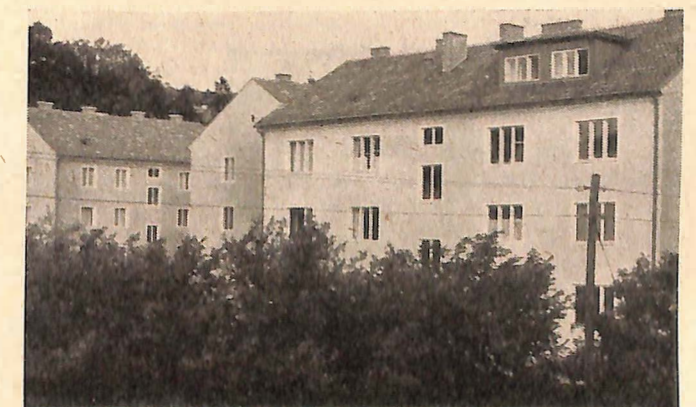
Ansicht aller drei zum Teil sichtbaren Wohnobjekte in Purkersdorf, in denen bereits 12 Gendarmenfamilien wohnen
