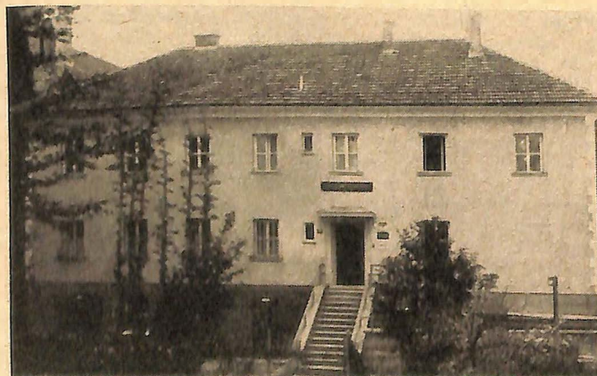
Die neue Gendarmeriepostenunterkunft in Bachmanning, Oberösterreich
