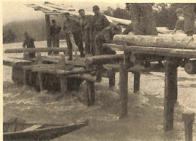
Abriegelung des Dammbrechens bei Uderns durch Pioniere
