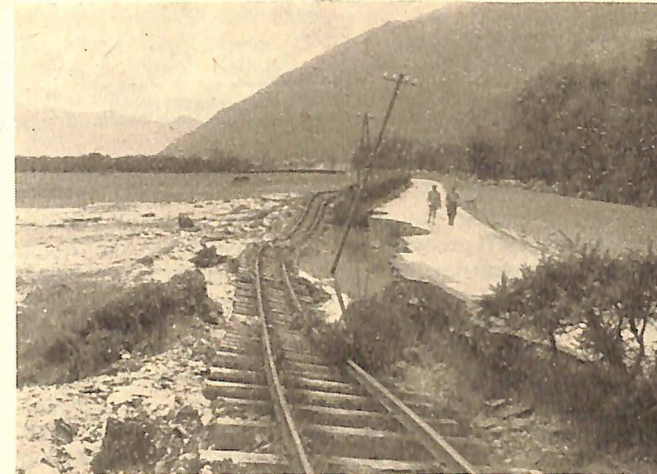
Das zerstörte Bahngleise der Zillertal-Bahn
