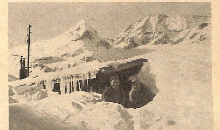
Die eingesetzten Beamten beim Verlassen der eingeschneiten Bauleiterbaracke
