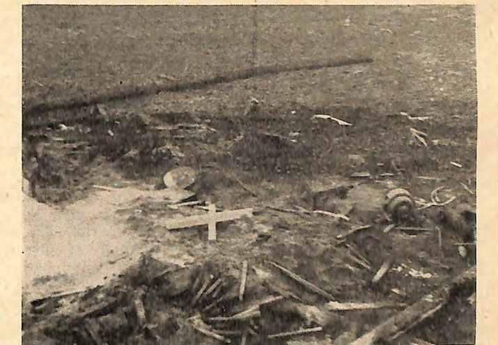
Das weiße Holzkreuz zeigt die Stelle an, wo die Kreissäge mit dem schadhafte Elektromotor vor dem Brand stand. (Brandausbruchsstelle.)
