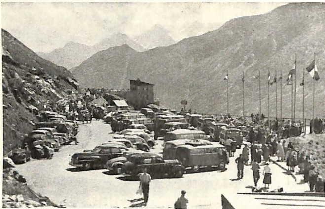
Parkplatz Freiwandack, der durch fünf Etagen unterirdisch vergrößert wird
