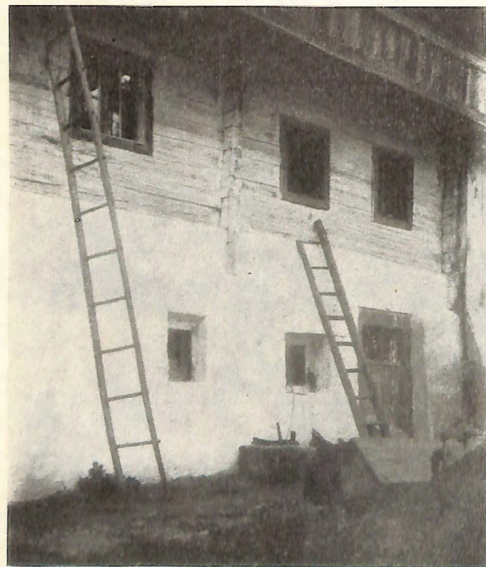
Talseitige Hausfront. Lange Leiter neben dem vergitterten Stubenfenster, durch welches der Täter geschossen hatte. — Kurze Leiter unter dem unvergitterten Küchenfenster, durch welches der Täter nach der Ermordung des Franz E. in das Haus eingestiegen ist
