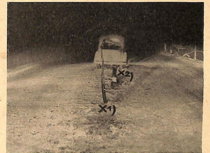
Rückwärtige Ansicht des Personenwagens nach dem Unfall in Fahrtrichtung. x 1) Lage des Toten; x 2) 20 Zentimeter Zwischenraum der unzusammenhängenden Brückenhälften, über welchem das Brückengeländer provisorisch aufgestellt war
