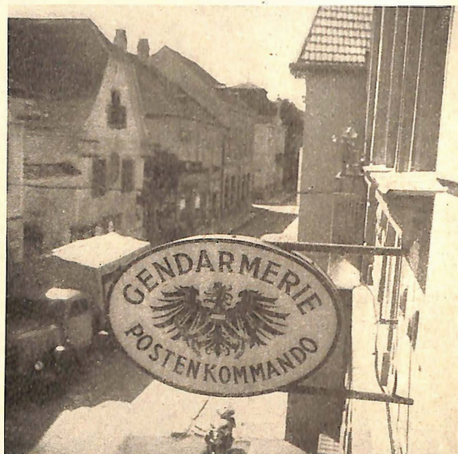
Blick vom Gendarmeriepostenkommando Pöchlarn auf die vom Hochwasser wieder frei gewordene Hauptstraße. (Vergleiche Bild 4 der Bilderseite.)
