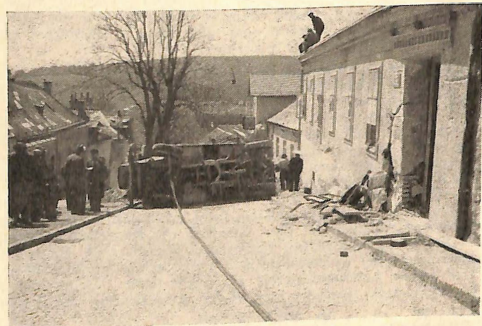
Technisches Gebrechen am Fahrzeug. Versagen der Druckluftbremsen eines Lastkraftwagens auf abschüssiger Fahrbahn
