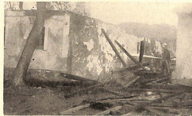
Niedergebranntes Objekt, bei dem das Feuer ausgebrochen war
