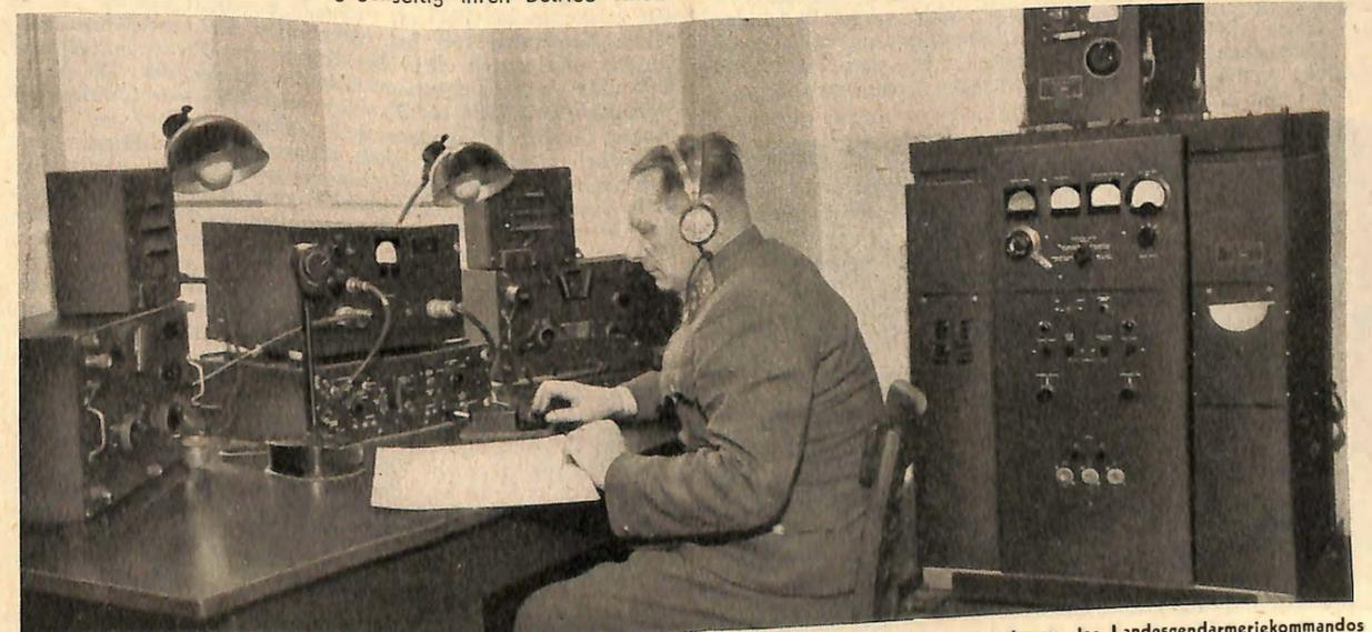
500-Watt-Funkanlage, wie sie bei einzelnen Landesgendarmeriekommanden als Leitfunkstelle errichtet wurden. (Funkraum des Landesgendarmeriekommandos für Niederösterreich)
