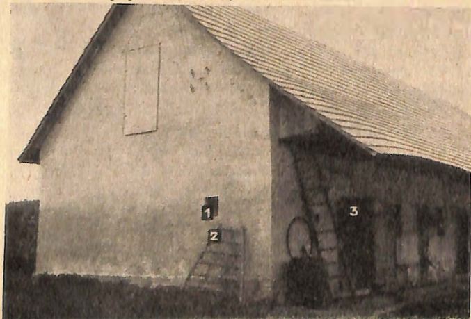
Das Stallgebäude mit dem vom Täter finanzierten, neu errichteten Dachstuhl. Das Fenster an der Stirnseite ist jenes, durch welches die brennende Zeitung geworfen wurde.
