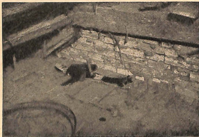
Bild 1: In dem Winkel zwischen der Dachfläche und dem Bretterfußboden stand eine brennende Kerze, deren Fuß mit ölgetränkten Lappen umgeben war
