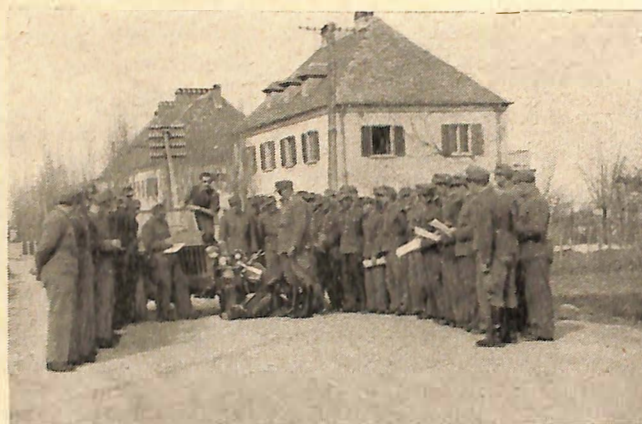
Rekonstruktion eines Verkehrsunfalles
