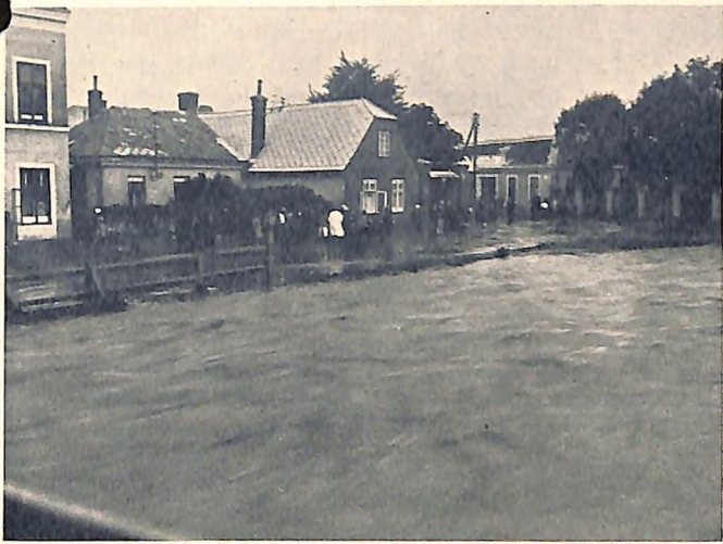
Der Liesingbach ist in Aggersdorf bei Wien um 2 Meter gestiegen. Die umliegenden Straßen wurden unter Wasser gesetzt.
