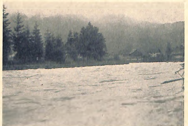
Ein Blick auf die Hochwasser führende Isar bei Scharnitz in Tirol. Die mit großer Gewalt einherbrausenden Wassermassen haben an öffentlichem und privatem Eigentum schweren Schaden angerichtet.
