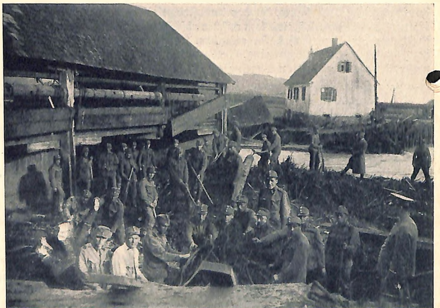
Überschwemmung im Raabtal (Steiermark). Die Wehranlage der Goditschmühle in Gleisdorf, die durch die vom Hochwasser mitgeführten Holzmassen verlegt wurde, sodaß die Raab einen Damm durchbrach und sich ein neues Flußbett schuf. Der neue Flußlauf ist auf dem Bilde sichtbar, ebenso auch das durch das Hochwasser am meisten bedroht gewesene Wohnhaus. Pioniere sind im Begriffe, das alte Flußbett von den angesammelten Holzmassen zu säubern.
