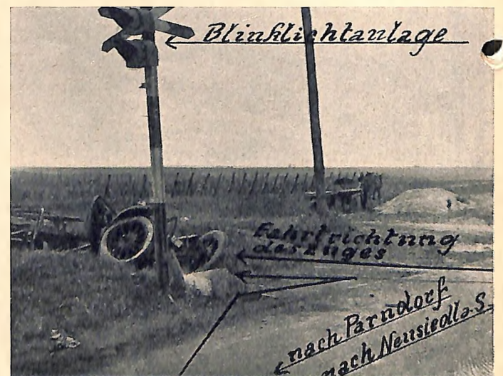
Auf der gesicherten, jedoch nicht abgeschrankten Bahnüberführung bei Parndorf (Burgenland) wurde ein Lastauto von einem herankommenden Personenzug erfasst und völlig zerkümmert. Die Führerkabine wurde dabei abgerissen und samt den beiden Insassen zur Seite geschleudert, sodaß letztere nur leicht verletzt wurden. Photo: Rayonsinspektor Wesely, Neusiedl am See.
