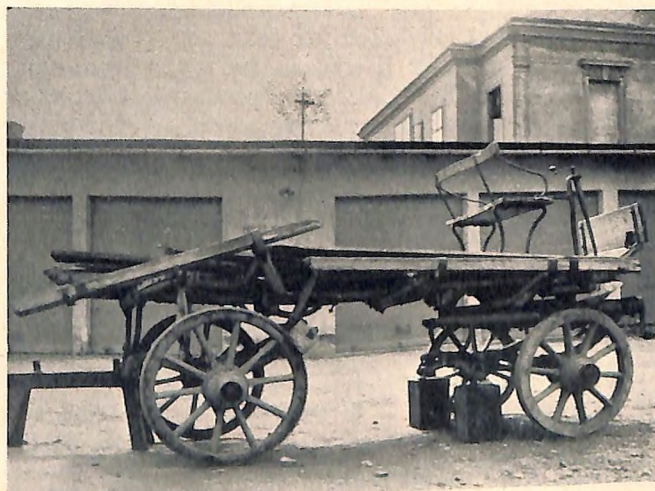
Der zerstörte Wagen des Lingler wurde wieder zusammen-gestellt. Auch hier läßt sich die Richtung der Gewalt feststellen. Der rechte rückwärtige Teil ist besonders in Mitleidenschaft gezogen, die rückwärtigen Wagenfedern sind gebrochen und nach vorne gedrückt. Im Holze der abgebrochenen Latte fanden sich Splitter der Windschuhscheibe.
