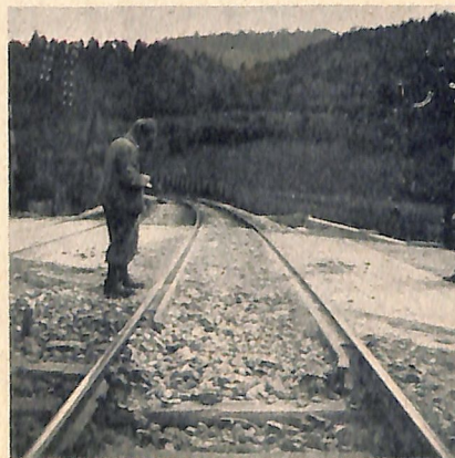
Überführung des Bahnkörpers durch die Italiener Bundesstraße. Man sieht auch das aufgewühlte Schotterbett und das von dem unter der Lokomotive verfeilt gewesenen Baumwurzelstrunk mitgeschleifte Schotter- und Sandmaterial auf dem Pflaster der Bundesstraße.
