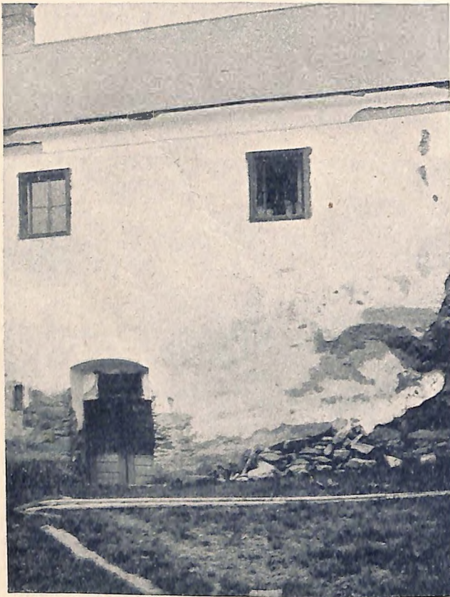
Das Fenster der Kammer, in der der Knecht Kogler geschlafen hat. Durch dieses Fenster sind die Mörder in das Innere des Anwesens Kogelbauer eingedrungen, indem sie sich über am Boden liegenden Leiter bedienten. Der Knecht Kogler hat das Eindringen der Mörder nicht wahrgenommen.
