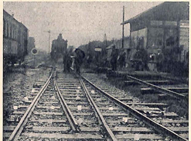
Auch hier kennzeichnen aufgelegte Papiertäfelchen die ur-sprüngliche Lage der Geleise. Es handelt sich um das rechte, freie Geleise, auf das der Zug umgeleitet werden sollte. Es wurde um 1,30 Meter seitlich verschoben. An dieser Stelle erfolgte die eigentliche Entgleisung.
