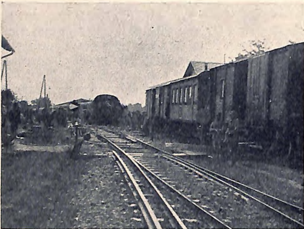
Der Wechsel in der Richtung Enns. Entfernung vom Vor-signal bis hierher 400 Meter. Von diesem Wechsel aus wurden alle Züge auf das rechte Geleise gelenkt, da das linke Geleise abgesperrt war.
