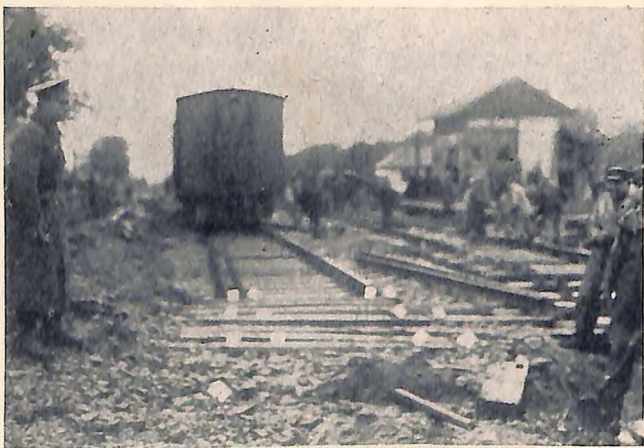
Die aus der Lagerung gerissenen Geleise. Die aufgelegten Papiertäfelchen bezeichnen die ursprüngliche Lage. Durch die Geschwindigkeit der schweren Maschine und des nachfolgenden Zuges wurde der gesamte Oberbau mit den Geleisen ver-schoben.
