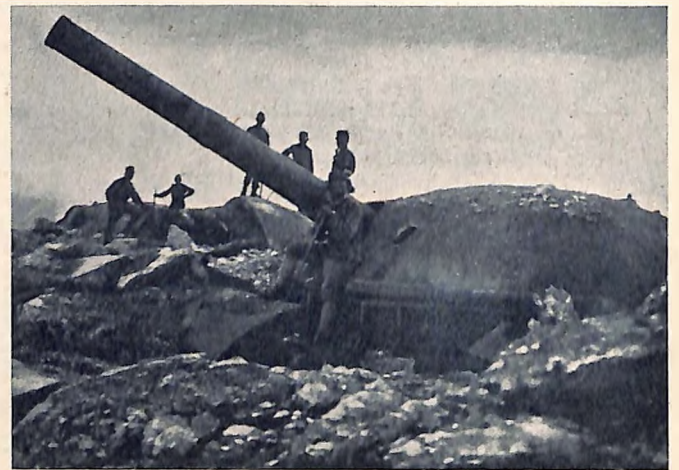
Die italienischen Forts nach der Niederkämpfung durch schwere österreichische Mörser. Große Panzerkuppeln für 15 Zentimeter-Turmhaubitzen wurden durch die Gewalt der Geschosse aus den Betondecken gerissen und weggeschleudert, 4 Meter starke Betondecken der Kasematten wurden zertrümmert. Die Forts Camponogno und Bereña waren zum Schweigen gebracht...
