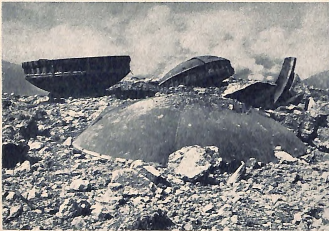
Die italienischen Forts nach der Niederkämpfung durch schwere österreichische Mörser. Große Panzerkuppeln für 15 Zentimeter-Turmhaubitzen wurden durch die Gewalt der Geschosse aus den Betondecken gerissen und weggeschleudert, 4 Meter starke Betondecken der Kasematten wurden zertrümmert. Die Forts Camponogno und Bereña waren zum Schweigen gebracht...
