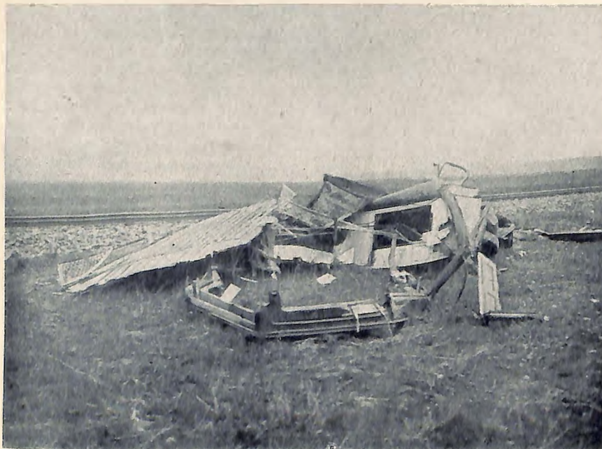
Die Trümmer der Autokarosserie, die samt den Insassen noch zirka 200 Schritte vom Zuge mitgeschleift wurde.
