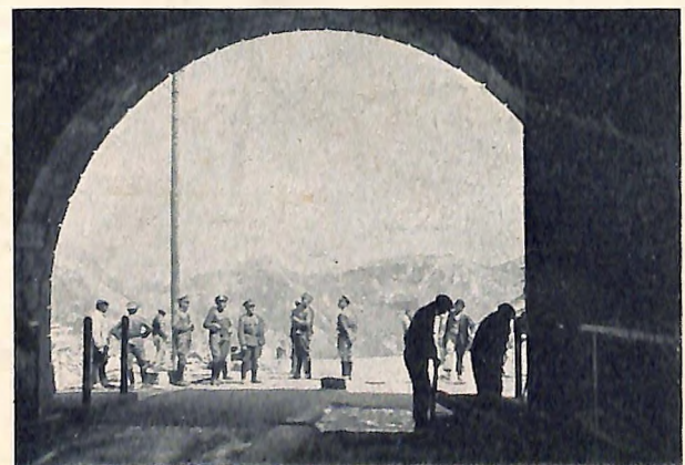
Hochtortunnel, Salzburger Seite, Blick gegen die Edelweißspitze, zu der eine Abzweigung der Straße führt, deren Röhren deutlich sichtbar sind. Sämtliche Photos: Prov. Gendarm Rindler.
