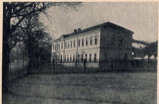
Das Gebäude der Göblasbruder Gendarmarief-Anwärtereschule.
