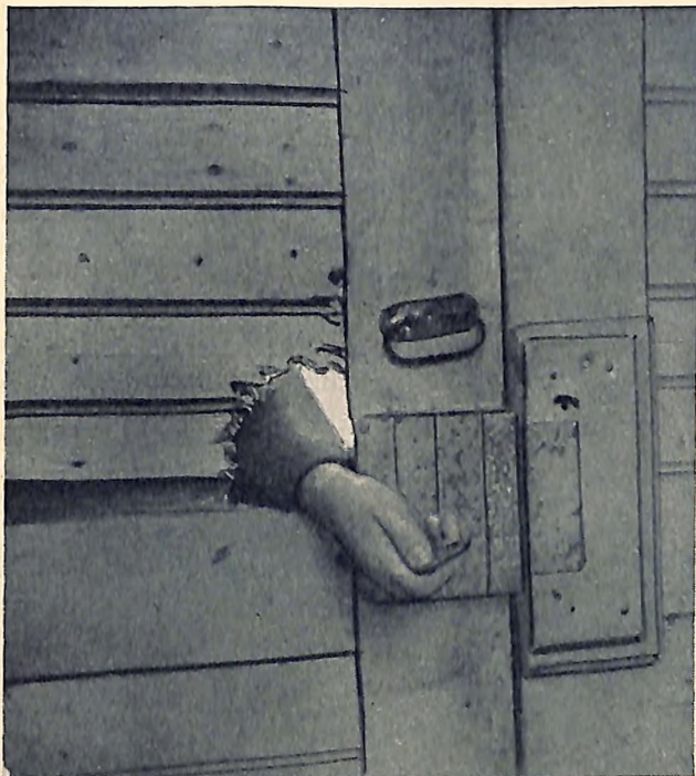
Das Bild zeigt die Doppeltür, die von einem Treppenraum in den Magazinsraum des Kaufmannes Schwarz führt. Die Türfüllung des rechten Flügels wurde — wie deutlich sichtbar ist — durch mehrere nebeneinander liegende Löcher angebohrt und durchstoßen. Auf dem Bilde ist ersichtlich, wie der innen steckende Schlüssel erfaßt und die Tür aufgesperrt wurde.
